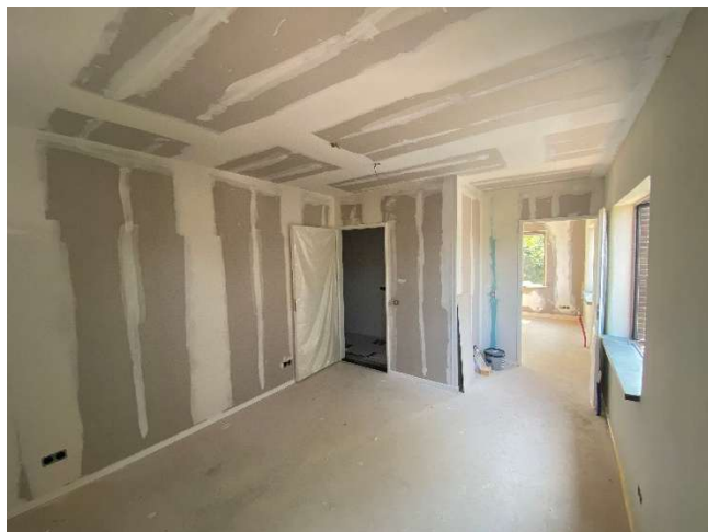
Appartement 1 e verdieping Dorpstraat zijde
